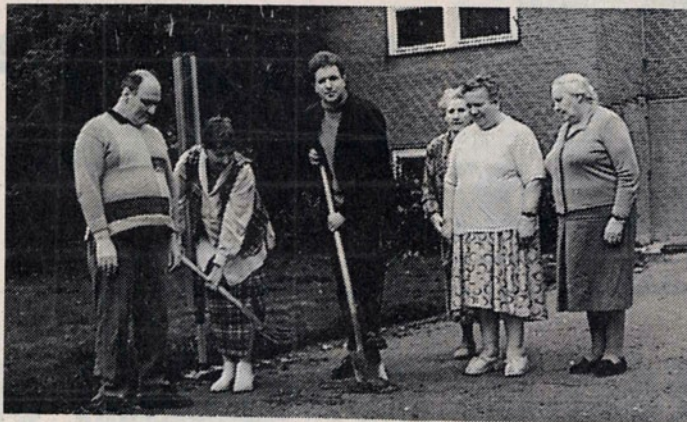
Heimleiterin Ilse Boonstra und Pascal Kuijpers machten den obligatorischen „Ersten Spatenstich“ für die Neu- und Umbaumaßnahmen am „Haus Sankt Josef“ in Kückhoven.
