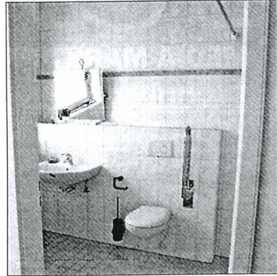
Blick in einen der seniorengerecht eingerichteter Sanitärräume. Foto: pki
