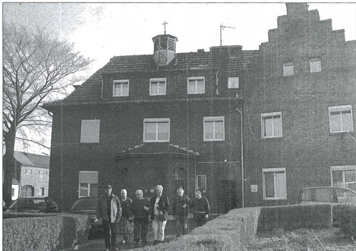
Rund um das „Haus St. Elisabeth“ beginnen die Arbeiten für ein dreiteiliges Gebäude-Ensemble. Bis Mitte 2005 sollen zusätzliche Pflege- und Arbeitsplätze geschaffen werden. Foto: Achim Theile
